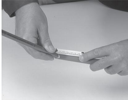
**2.** Nettoyer les deux éléments à assembler et marquer la profondeur sur le tube correspondant à l'emboîture du raccord.
